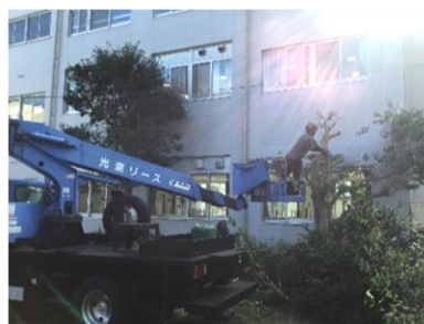
【作業されている様子】
